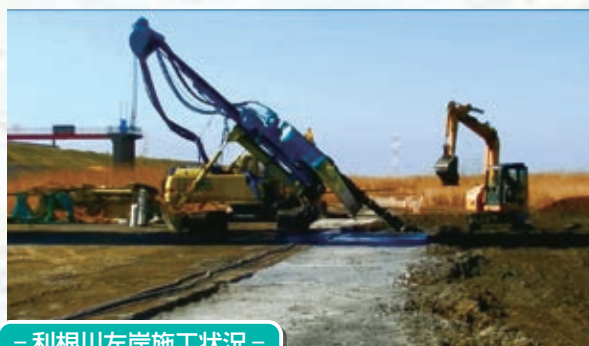
- 利根川左岸施工状況 -
